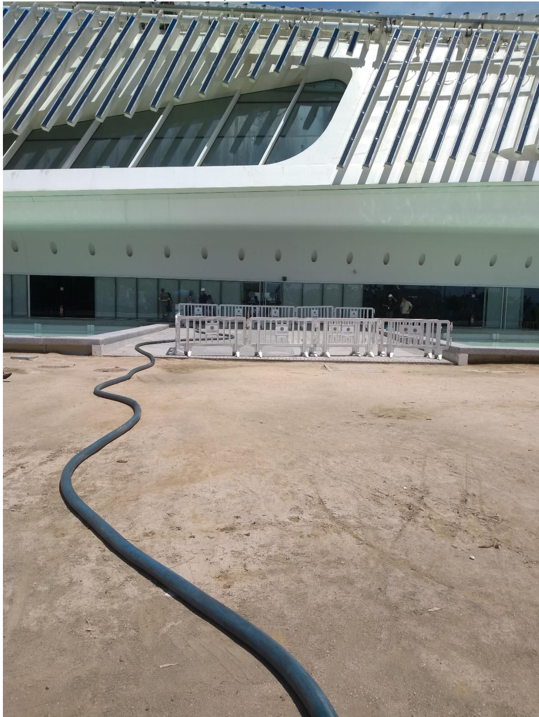
Foto 4: Área de construção de rampa.
