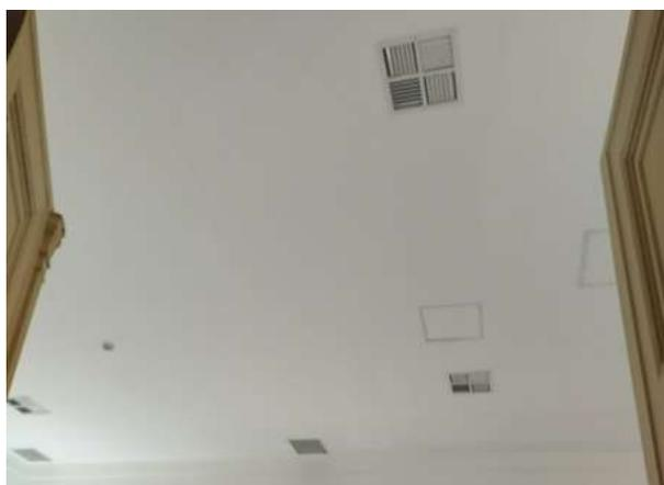
**FOTO 11: Adequação e correção acesso de serviço dos equipamentos de climatização – salas do primeiro pavimento (Mostra de Longa Duração)**
