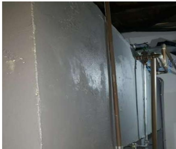
**FOTO 42: Revisão e pintura de reservatórios superiores de água potável.**
