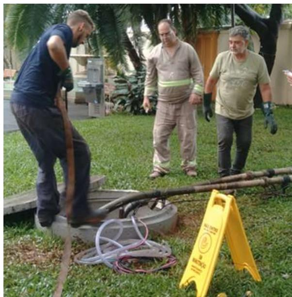
**FOTO 5: Manutenção corretiva de bombas de drenagem vertical do poço externo de esgoto.**
