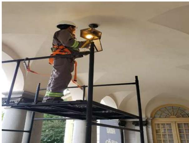
**FOTO 17: Manutenção condutores de alimentação, lustre de iluminação e varanda térreo.**
