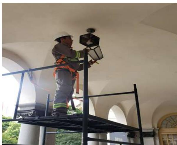
**FOTO 16: Manutenção condutores de alimentação, lustre de iluminação varanda térreo.**
