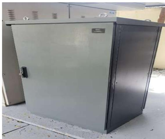
**FOTO 34:** Manutenção QTA (Quadro de Transferência Automática – Rede Concessionária / Grupo Moto de Gerador de Energia Elétrica)
