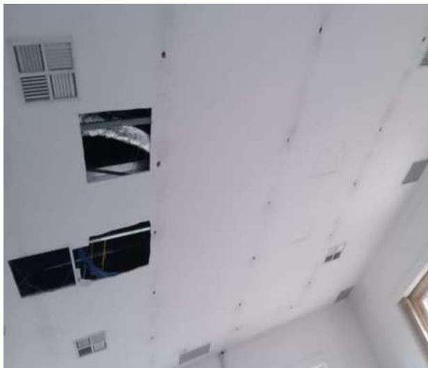
**FOTO 7: Adequação e correção acesso de serviço dos equipamentos de climatização – salas do primeiro pavimento (Mostra de Longa Duração)**
