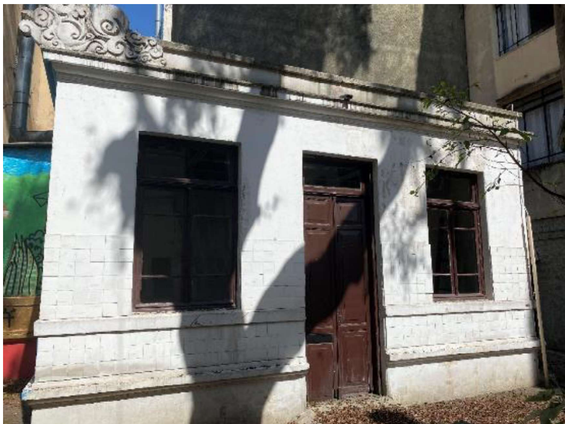
Figura 35 - ÁREA 6: vista da fachada norte do Bloco D.
