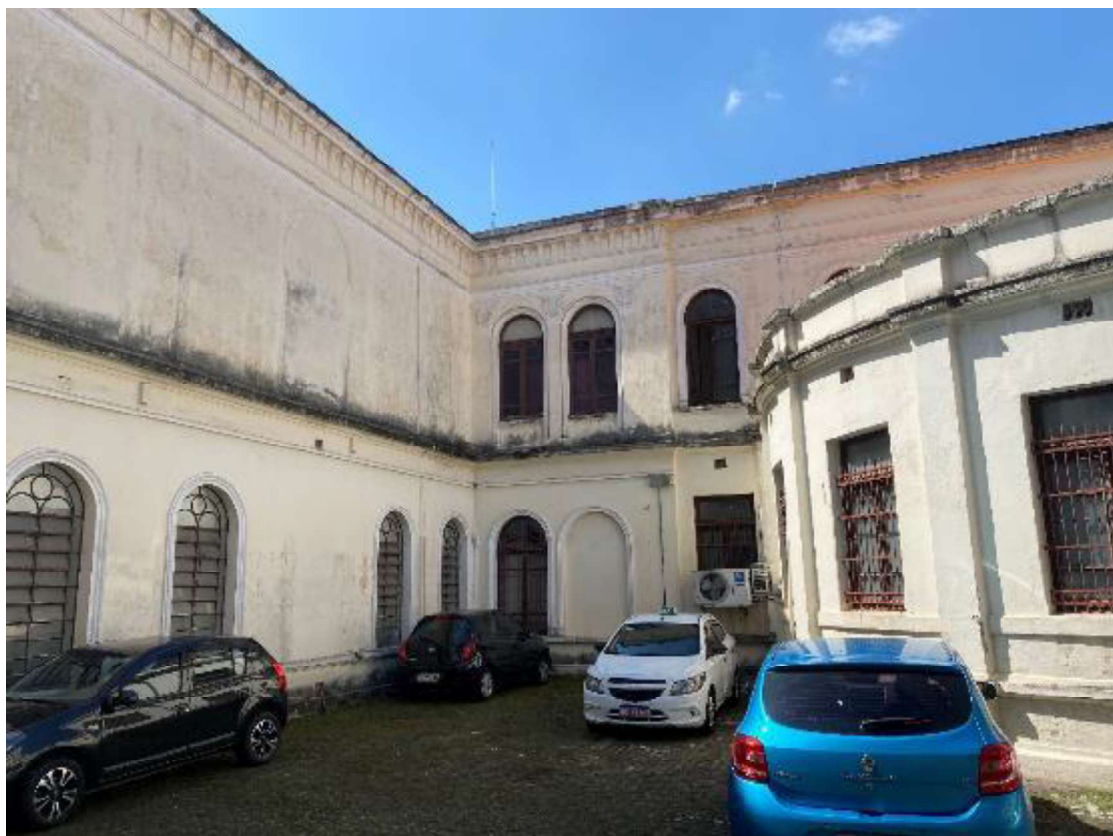
Figura 19 - ÁREA 3: acima, vista do estacionamento junto a lateral oeste do Bloco A.
