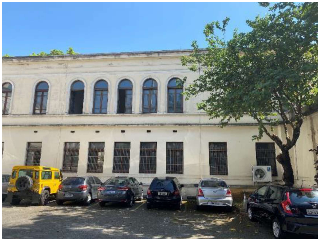
Figura 13 - ÁREA 2: acima, vista do estacionamento junto à lateral leste do Bloco A
