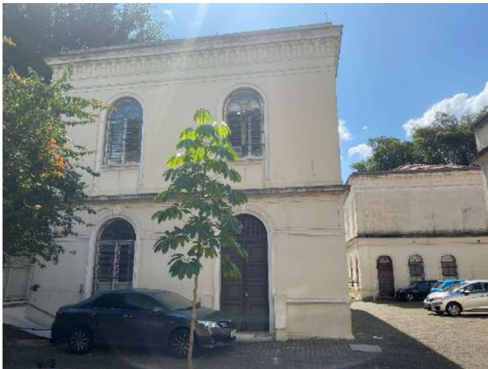
Figura 23 - ÁREA 4: acima, vista da fachada sul do Bloco B.
