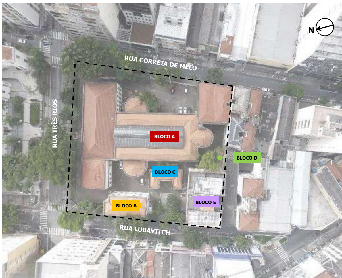
Situação geral do conjunto Imagem base: Google Maps, 2022.
