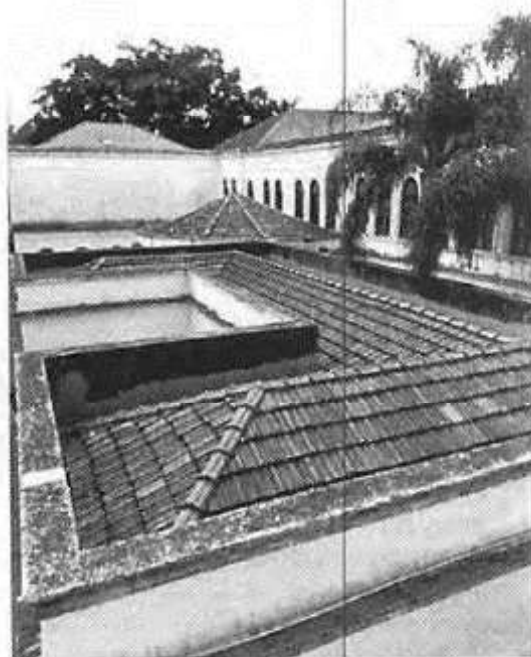
Foto 46: Vista da cobertura.
