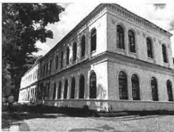
Foto 01: Vista da fachada principal.
