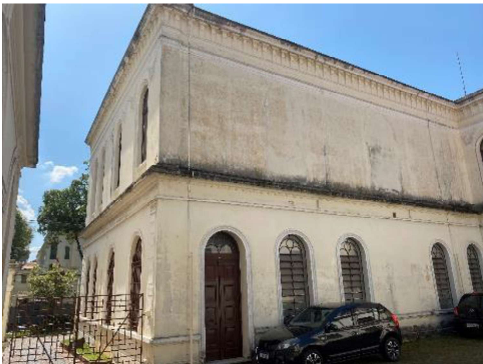
Figura 18 - ÁREA 3: abaixo, vista do estacionamento junto a lateral oeste do Bloco A.
