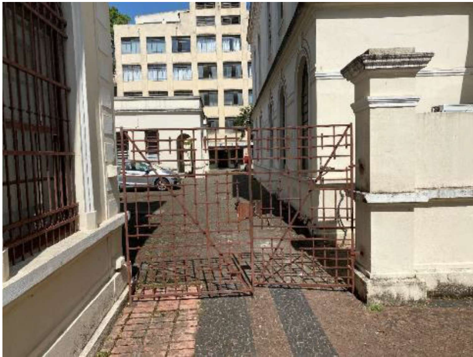
Figura 17 - ÁREA 3: acima, vista do portão de acesso à área 3.
