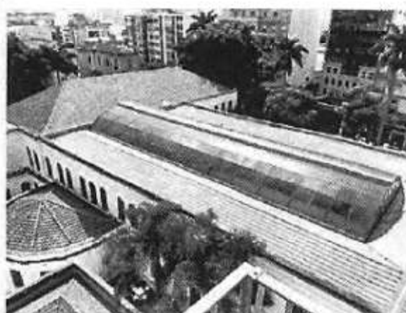
Foto 02: Vista da cobertura.
