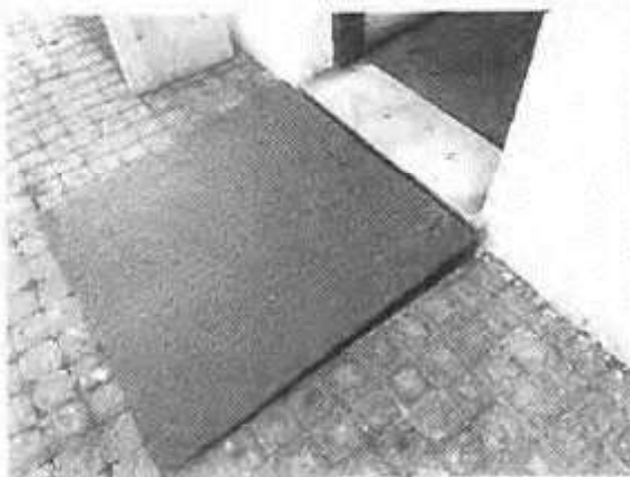
Foto 47: Rampa para acessibilidade ao bloco.
