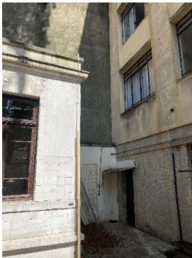
Figura 33 - ÁREA 6: acima, vista da área entre os bloco D e E.
