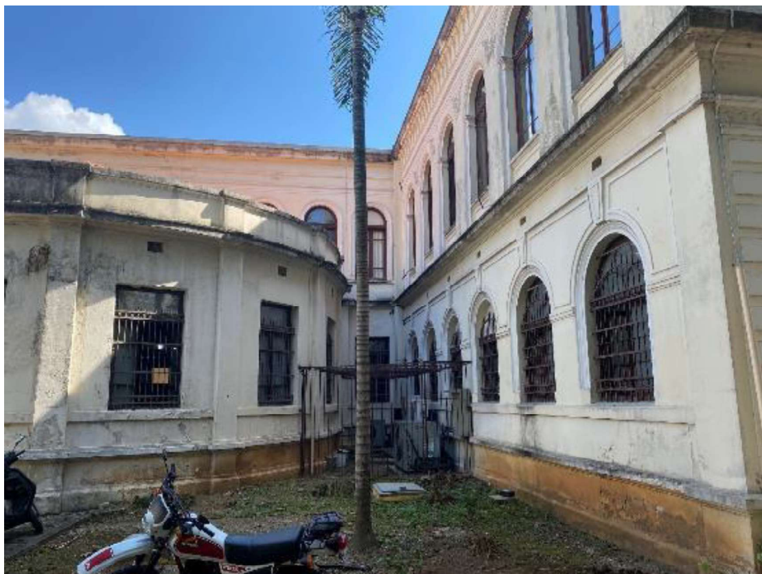
Figura 15 - ÁREA 2: acima, vista do estacionamento junto à rotunda leste do Bloco A
