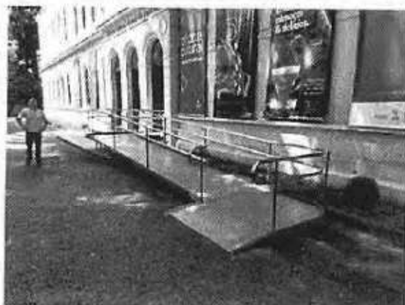
Foto 03: Vista da rampa de acessibilidade.
