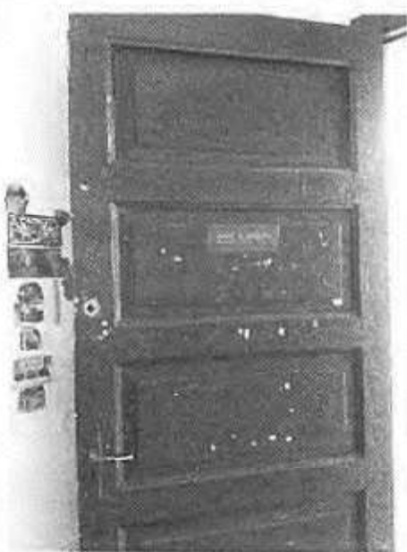
Foto 49: Porta de acesso ao bloco.
