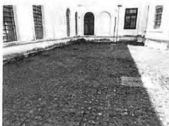
Foto 108: Área externa entre os blocos A, C e B.
