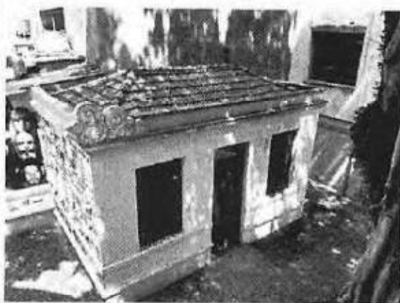
Foto 51: Vista da fachada e cobertura do bloco.
