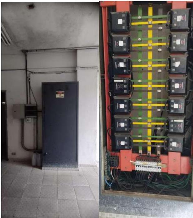
**FOTO 35:** separação quadro elétrico para fornecimento de energia para nobreak CPD prédio E. (antes)
