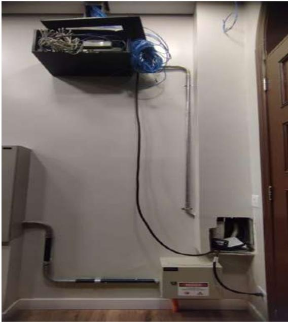
**FOTO 17:** Mino DIO Ponto de comunicação da Infra e fibra subterrânea prédio B e A rack Prédio B.
