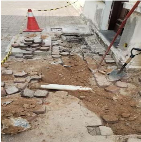
**FOTO 05:** Execução de cabeamento de fibras ópticas
