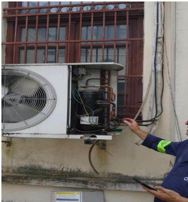
**FOTO 97:** Vistoria nas máquinas de ar-condicionado
