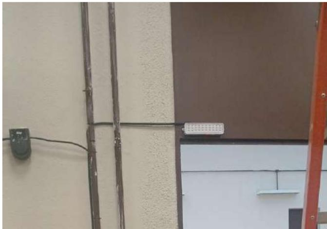
**FOTO 123:** Conservação sistema de iluminação de emergência.
