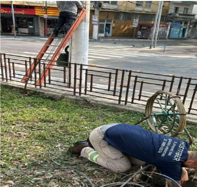
**FOTO 03:** Execução de infraestrutura para comunicação de rede entre os prédios A e B, passagem poste e caixas internas.
