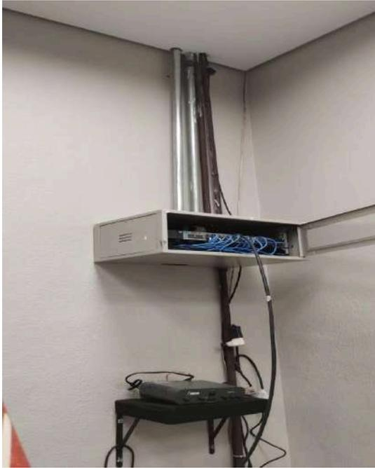
**FOTO 21:** MINI DIO com 3 vias comunicação entre racks no prédio A da sala 7 a sala 16.
