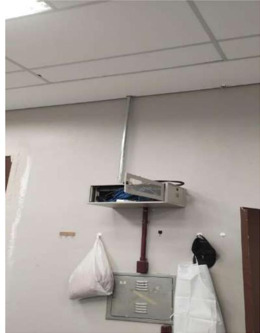
**FOTO 22:** MINI DIO com 3 vias comunicação entre racks no prédio A da sala 7 a sala 40.
