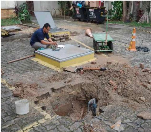
**FOTO 125:** Conserto de vazamento na tubulação hidráulica responsável pelo abastecimento dos reservatórios de água.
